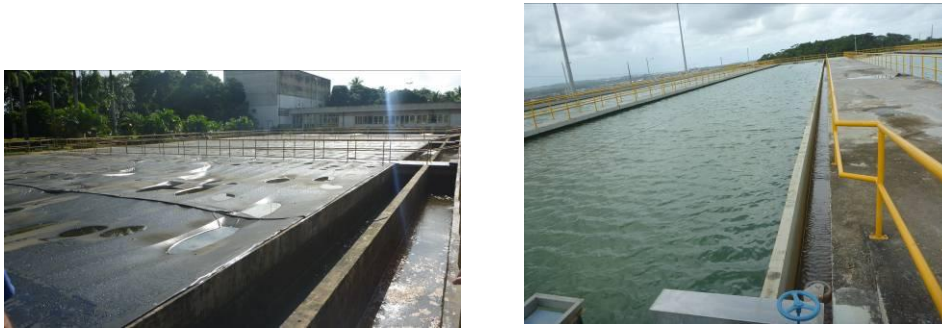
Figura 3: Tanques de decantação da ETA-1 e ETA-2.
